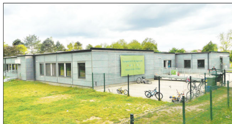
Die Holzmodule: Aktuell ist hier noch die Kita „Neckar-Krotten“ untergebracht. Wenn die Einrichtung im Sommer in ihr neues Quartier zieht, stehen die Module leer. Foto: Kraus-Vierling
