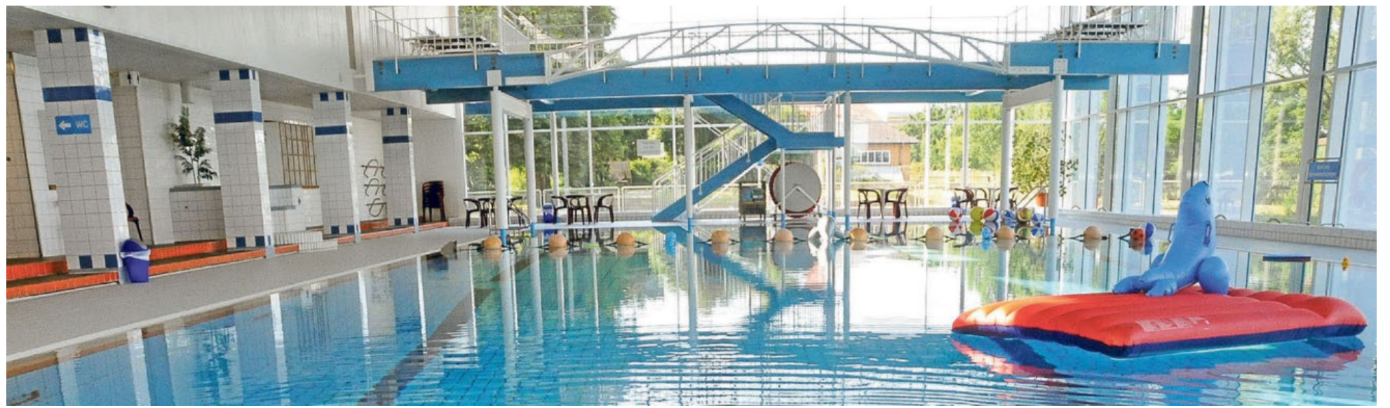
Das beliebte Freizeitbad in Neckarhausen wird ab Ende August umfangreich energetisch saniert. Fotos: nip
